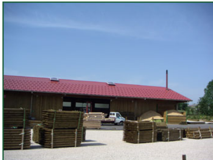
Station de traitement autoclave
